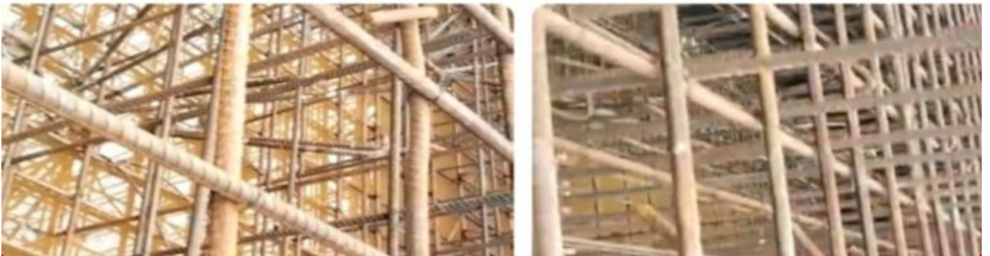
Proyek Jembatan Gantung
